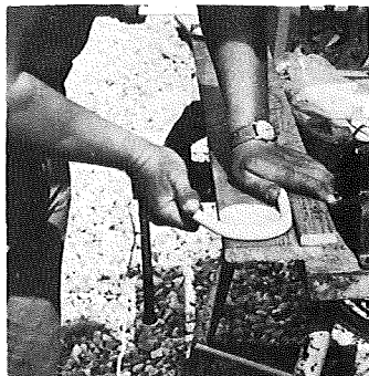
Figur 6, til venstre. Skabelon for rør til indstøbning. Skabelonen består af en bundplade, hvorpå der er monteret to runde låg fra marinedåser. Om disse låg bukkes rørene med en almindelig bukkefjeder, og til styring af rørene er der påsat en bagliste.
