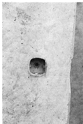
Figur 30. Afbryderdåse indstøbt i et 2M ben. Som det ses, kan det lade sig gøre at få plads til dåsen, men i dette tilfælde er kablet ikke indlagt.
