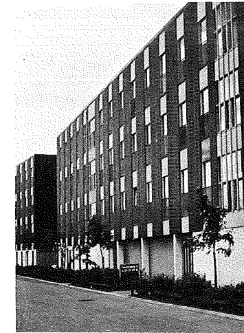
Figur 1. Foto af forsøgsbyggeriet. Facaderne er opbygget som en skeletkonstruktion. Skillevæggene udgøres af betonelementer, gipsplader på stålskelet eller autoklaveret letbeton. Gulvene er trægulve på strøer, undtagen i badeværelser. Loftene er underside af dækkonstruktionen.
